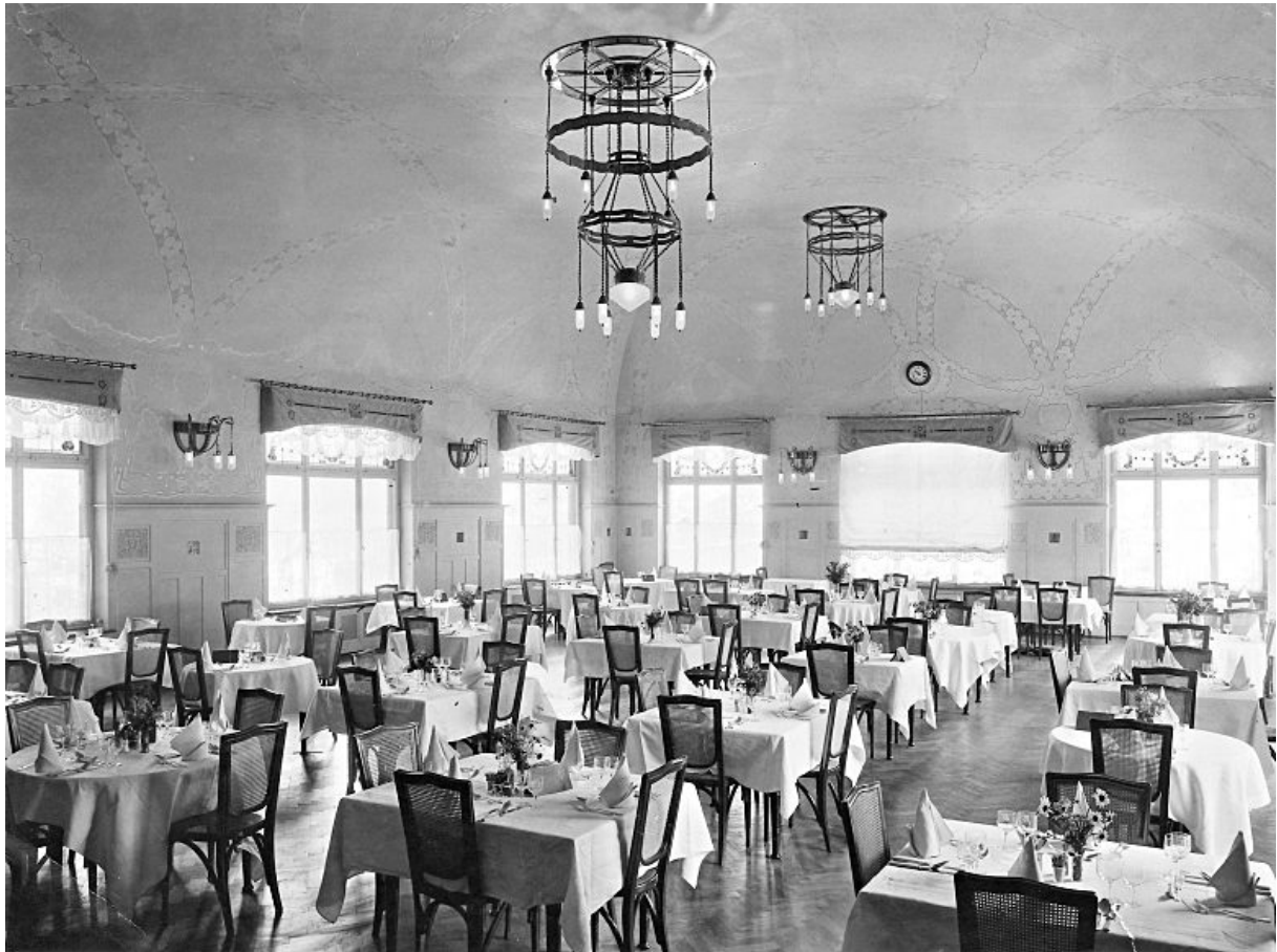
Der Speisesaal des Kurhauses Bergün im originalen Zustand
